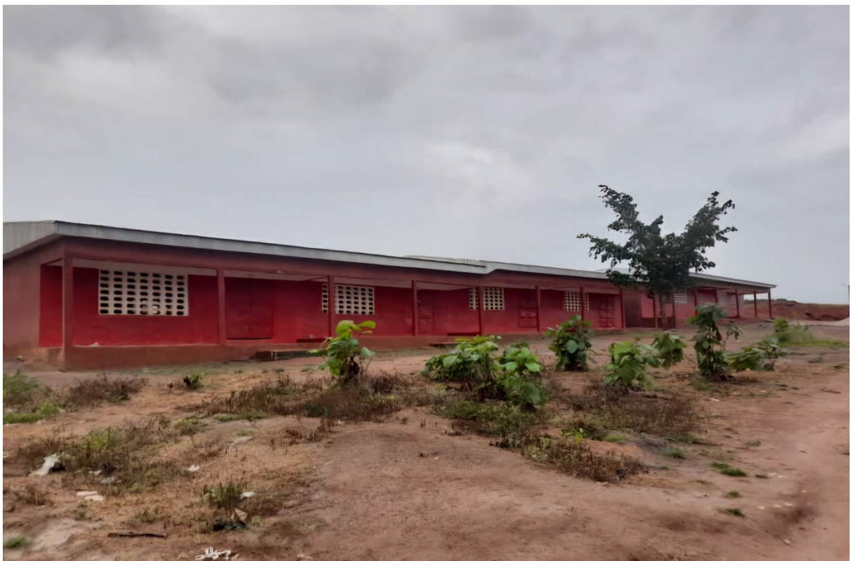
Die ganze Schule Sokouradjan 6 mit sechs Klassenzimmern und einem Direktionsbüro erstrahlt in den Schweizer Farben rot-weiss
